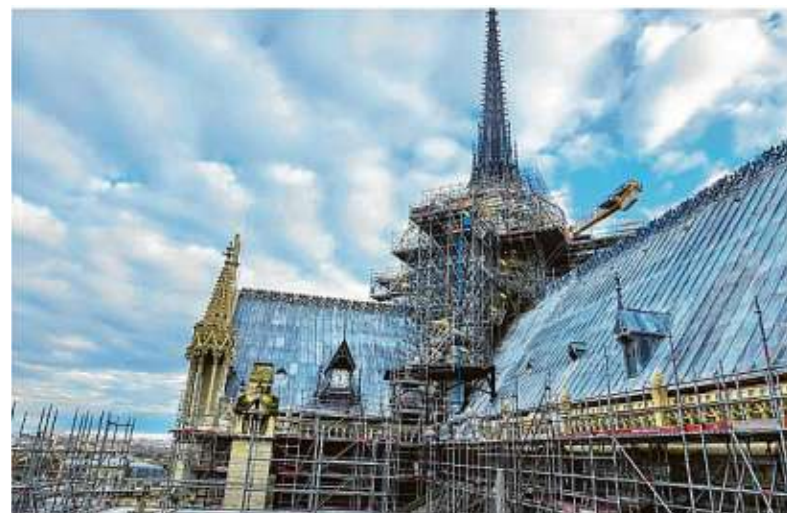
Auch wenn Notre-Dame mittlerweile wieder geöffnet ist, sind die Restaurierungsarbeiten doch noch nicht ganz abgeschlossen – wie das Gerüst um den Vierungsturm zeigt. Fotos: Walter Bauer
