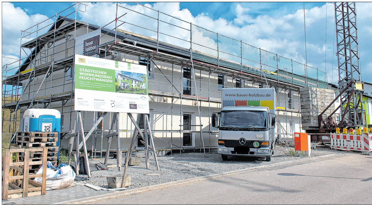
Dieses neue Mehrfamilienhaus im Baugebiet „Röschenhof“ soll am Ende des Jahres schlüsselfertig an die Stadt Feuchtwangen übergeben werden.
