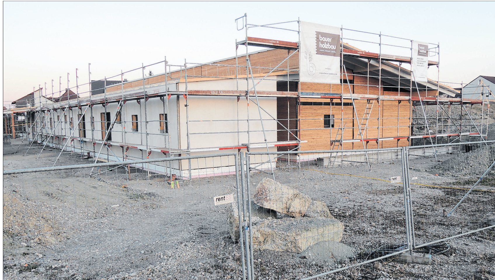
Die Baustelle an der Schwalbengasse in Schnelldorf: Wenn der Zeitplan weiterhin eingehalten werden kann, dann können die Mädchen und Buben zum Auftakt des neuen Kindergartenjahres im September in das „Schwalbennest“ einziehen. Foto: Peter Zumach
